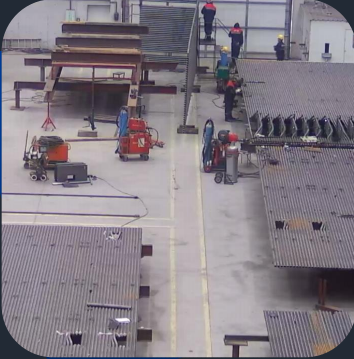
Kazan Duvar İmalatları
